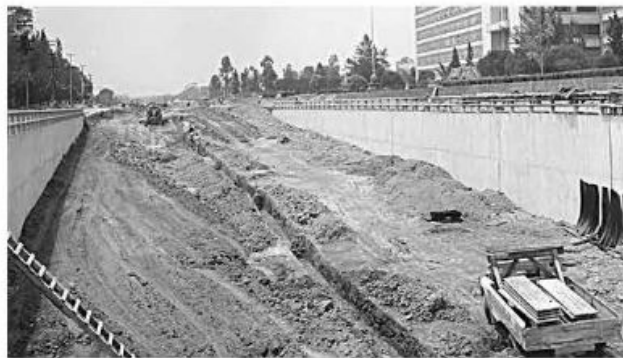
4.26 Obras de entubamiento del río La Piedad en la Ciudad de México, para llevar a cabo la construcción de una vía rápida, el Viaducto, en 1949.
